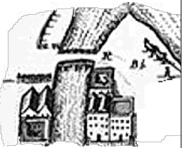
Brücke über die Ludl
